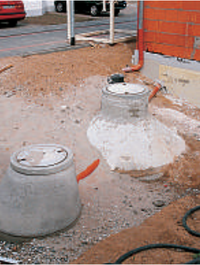
Filter, Regenwasserspeicher, Sickerschacht
