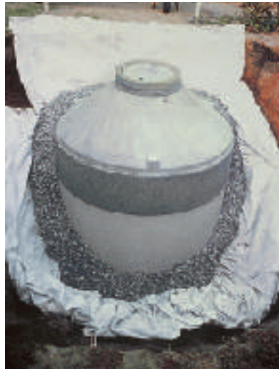
Regenwasserspeicher kombiniert mit Rigolenversickerung
