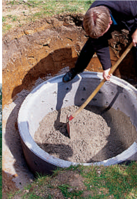
Schachtversickerung im Bau
