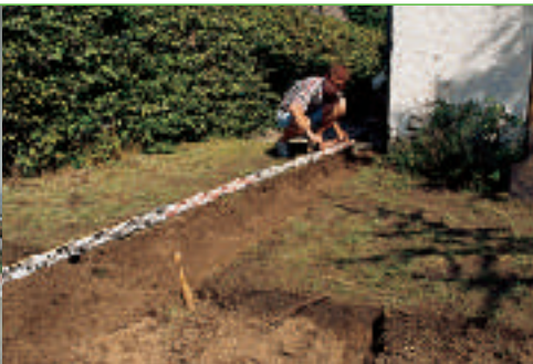
Oberflächige Zuleitungen von Regenwasser in Mulden
