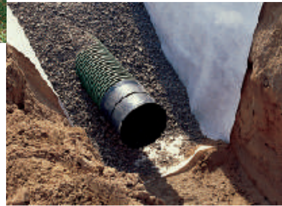
Rohr-Rigolenversickerung im Bau
