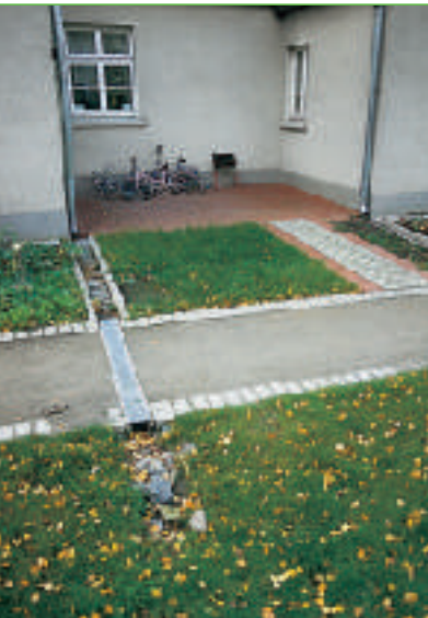
Oberflächige Zuleitungen von Regenwasser in Mulden
